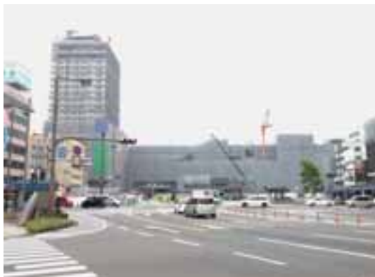
平成27年3月開業に向けて工事が進むJR大分駅 (平成26年9月30日筆者撮影)
