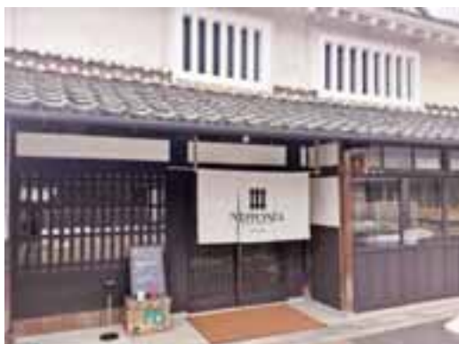
～旧山陰街道沿いにあるNIPPONIAの宿 ONAE棟～ 元銀行経営者の住居で、篠山城下町の町屋の特徴を活かしたりノベーションを実施
