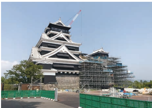
復旧工事中の熊本城天守閣
