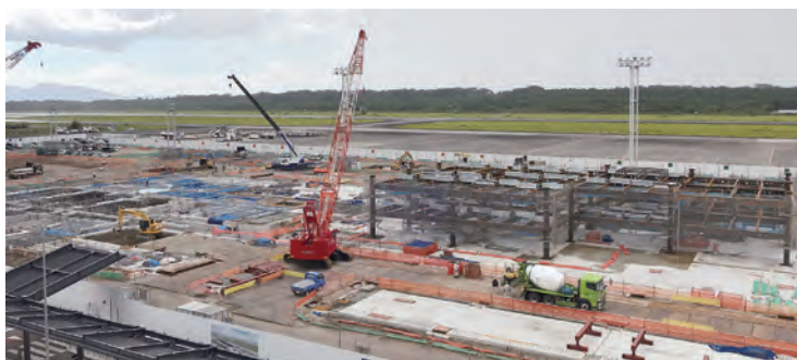
工事中の新旅客ターミナルビル
