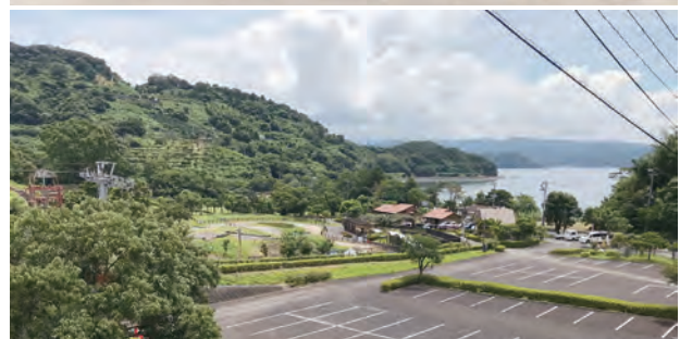
工事中の球磨川流域道路
