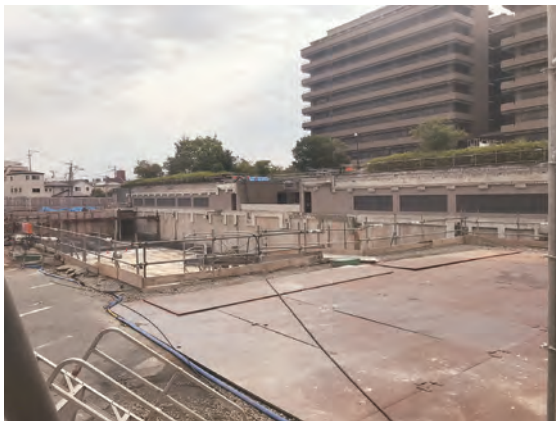
(2021年8月8日 筆者撮影 完成イメージは現場外壁より)
